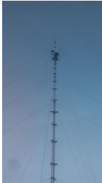
Gambar 6. Pemasangan Tower dan Hardware Jaringan
